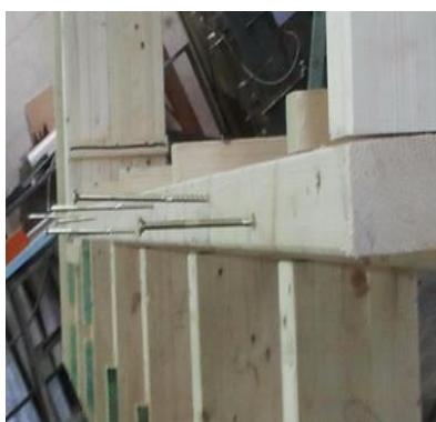
3. Den Aufbaurahmen fest mit dem Sparren bzw. Wechsel verbinden! Befestigung durch lange Senkkopf – Holzschrauben siehe Beschreibung im Aufmaßblatt.
