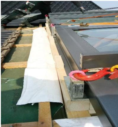
5. Hilfsplatten aus z.B. 4 x 6 Dachlatten am unteren Aufbaurahmen befestigen/anschrauben. Anzahl der Hilfsplatten ja nach Größe und Gewicht des Fensters zwischen 2 – 6 Stück.
